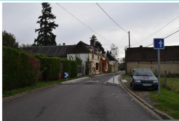
Chicane aménagée à Blacourt (Tecurbis, 2023)
